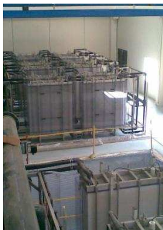
Obrázek 19: Schéma a fotografie technologie firmy MEGA a.s. pro demineralizaci vody určené pro užitkové účely
