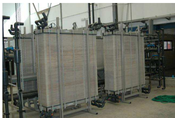
Obrázek 18: Blokové schéma a fotografie technologie firmy MEGA a.s. pro zpracování odpadní vody určené pro závlahy na Kanárských ostrovech
