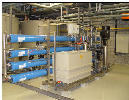
Obrázek 13: Blokové schéma a fotografie bezodpadové integrované technologie firmy MEGA a.s. pro zpracování kalištních síranových vod z těžby uranu v České republice
